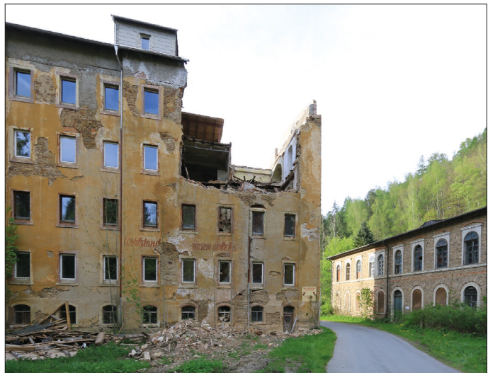
Zustand nach der Schadensbeseitigung am Dach
