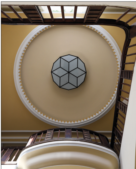
Treppengalerie im Haupteingang des Ernst-Seifert-Hauses
