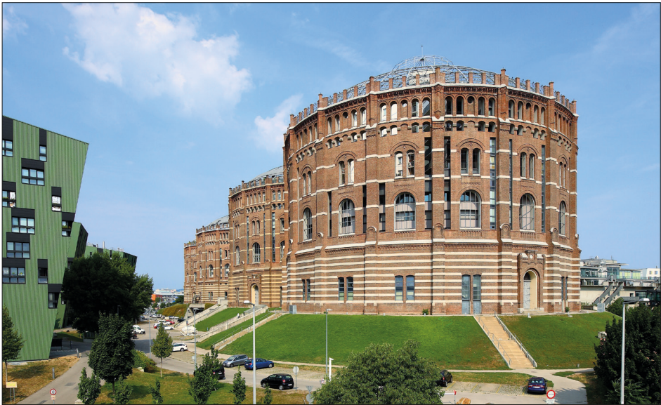
Zu Wohngebäuden umgebaute Gasometer in Wien
