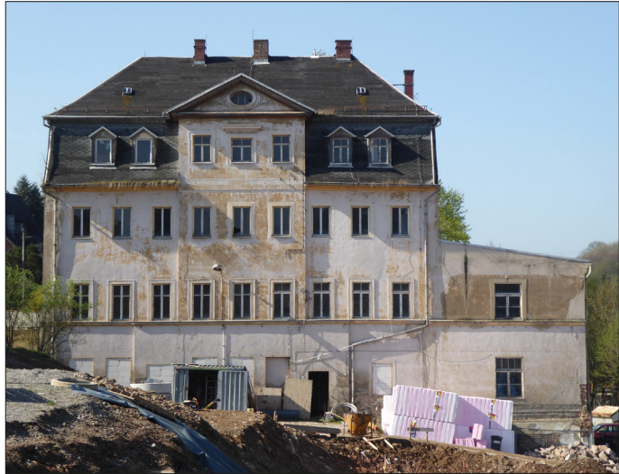
Bauzustand der Schafwollspinnerei Wolkenburg im Jahr 2018
