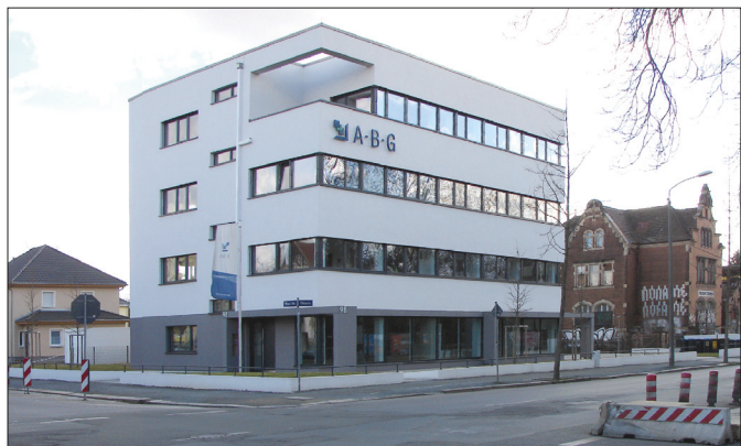
Neubau am Bahnhof Dresden-Strehlen
